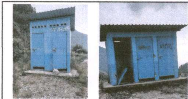
Foto 5: Fabricación e instalación de puertas de metal en baños
