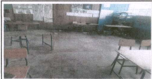
Foto 2: Sustitución de piso de cemento liquido Por piso ceramico
