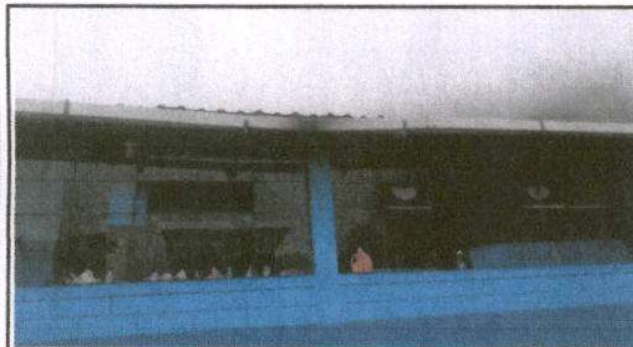
Foto 3: Sustitución de canal de metal
